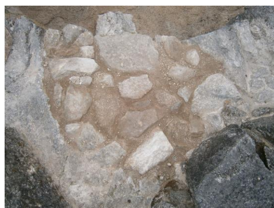
Vista de detalle da argamasa utilizada previa y posteriormente ó acabado final
