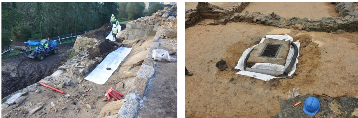
Vista de detalle da colocación dos drenaxes na falsabraga e no pozo.
