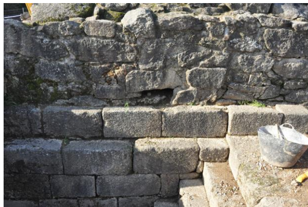
Vista de detalle de reparación de ócos nos paramentos do xacemento
