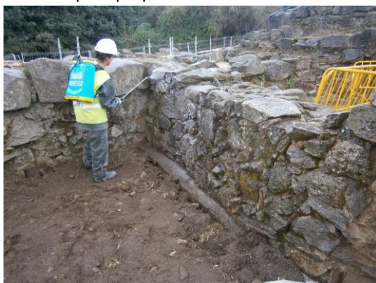
Aplicación de biocidas e muro (UE2200) e resultados na fonte 1
