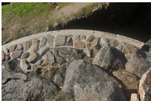
Vista de detalle da argamasa utilizada previa y posteriormente ó acabado final
