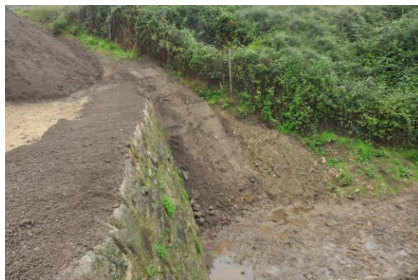
Vistas de detalle do proceso de taludado na falsabraca e no torreón este da muralla
