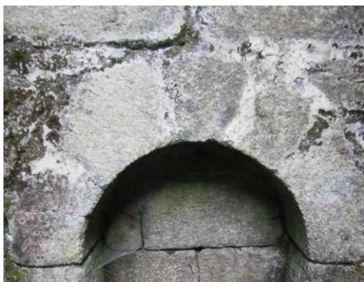
Vista de detalle do estado de conservación dos enlucidos da fonte 1
