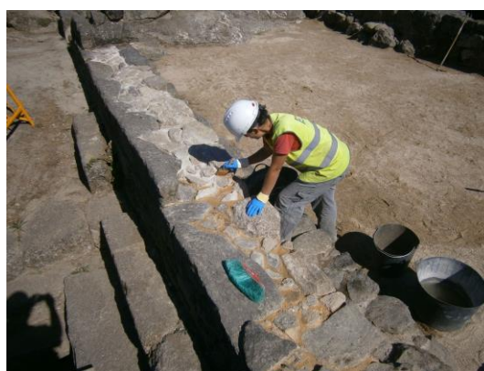
Retacado do paramento e tinción do morteiro
