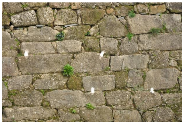
Vista xeral e de detalle da colocación das probetas de xeso no lenzo sur e leste da falsabragal
