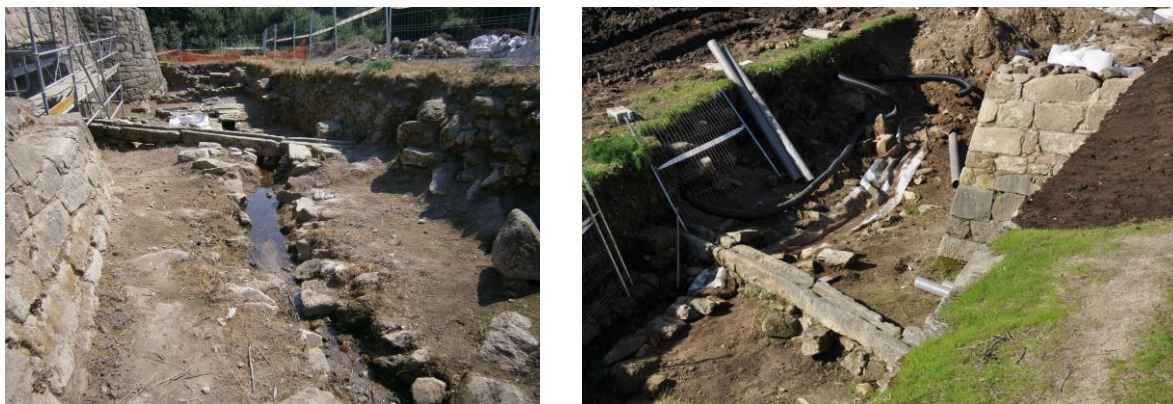
Vista de detalle da colocación do tubo microperforado na canle situada no exterior do castelo
