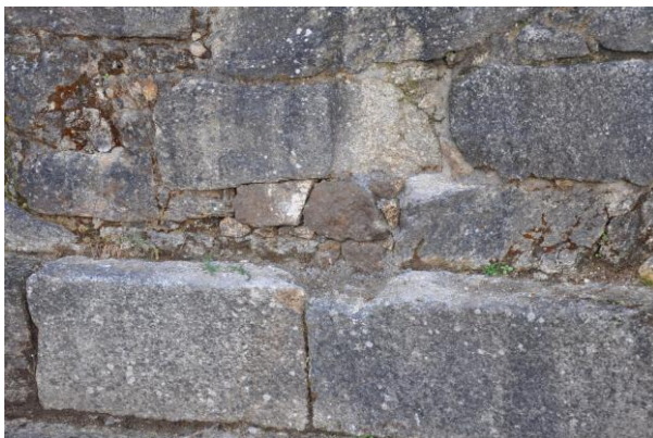
Vista de detalle de reparación de ócos nos paramentos do xacemento
