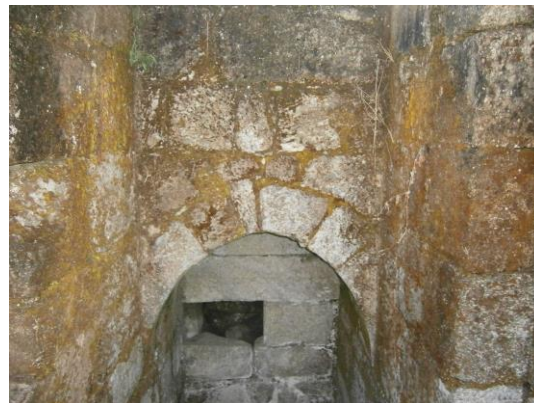
Aplicación de biocidas e muro (UE2200) e resultados na fonte 1
