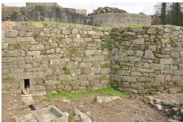
Vista xeral e de detalle da colocación das probetas de xeso no lenzo sur e leste da falsabragal
