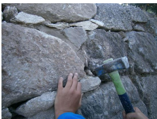
Retacado do paramento e tinción do morteiro
