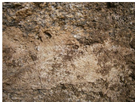
Vista de detalle do estado de conservación dos enlucidos da fonte 1
