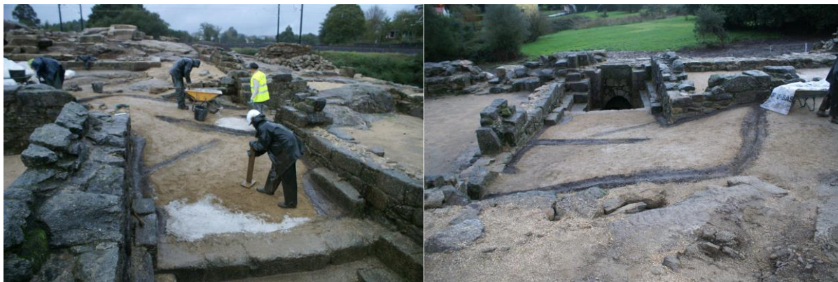
Vistas de detalle dos traballos realizados na rampa de acceso á fonte 1
