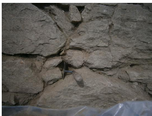
Vista de detalle da degradación do afloramento e perda de material constituínte nas estruturas
