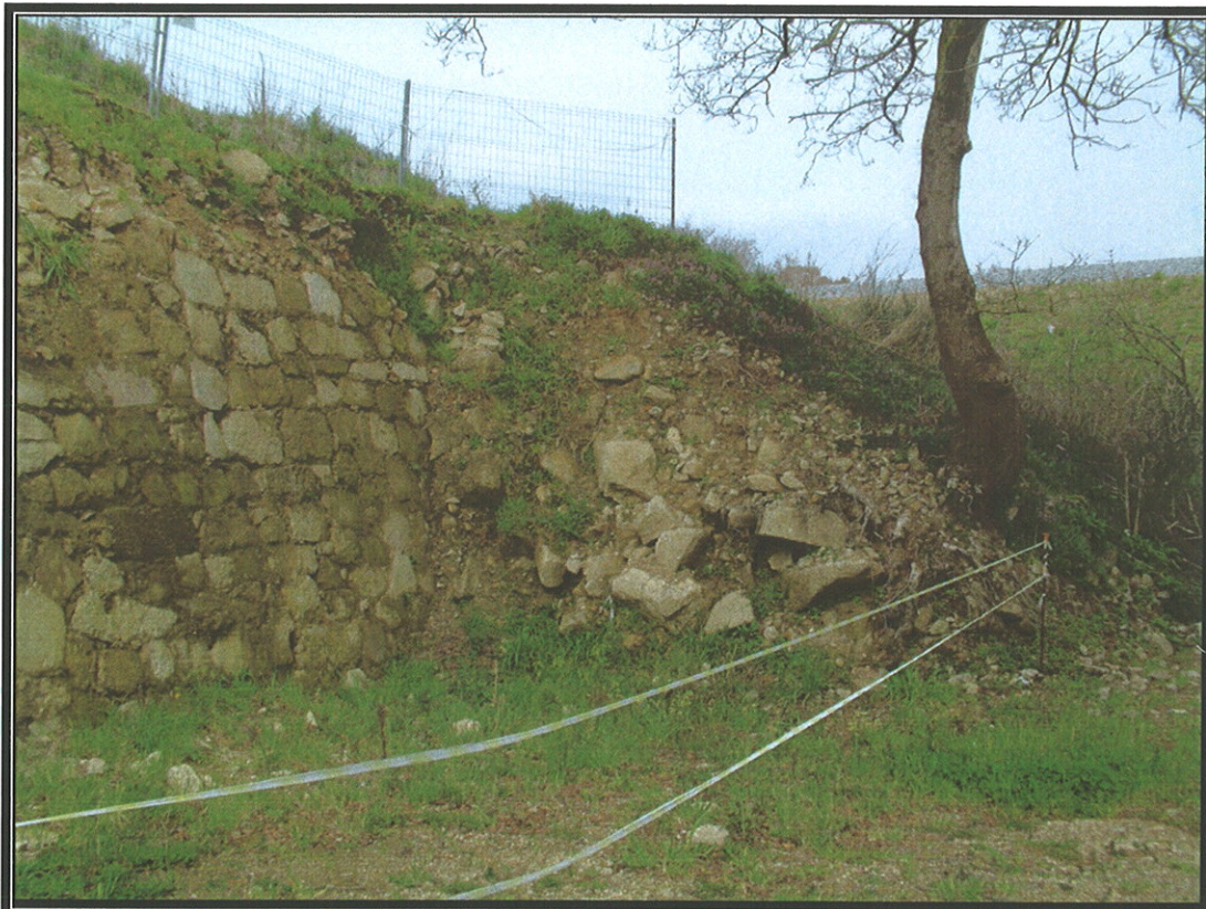
Vista da zona de actuación antes de comezalos traballos.
