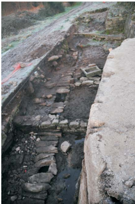
Detalles dos procesos de recuperación da canle principal de drenaxe que evacua a auga do manantial sito ao norte do castelo cara ao sur.
