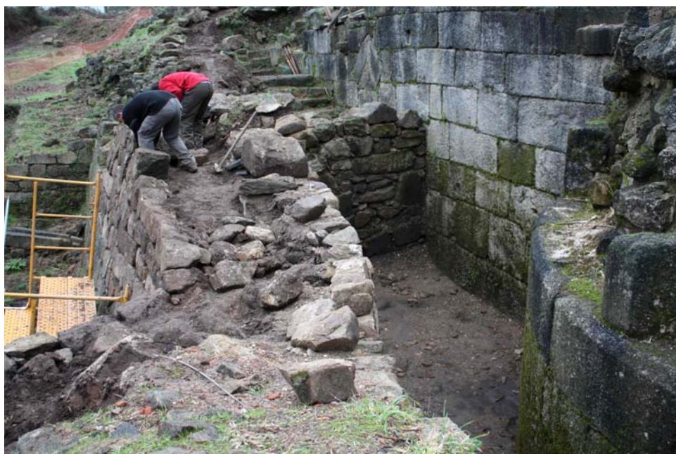
Traballos de restauración e recuperación de lienzos na antemuralla unha vez realizada a anastilose
