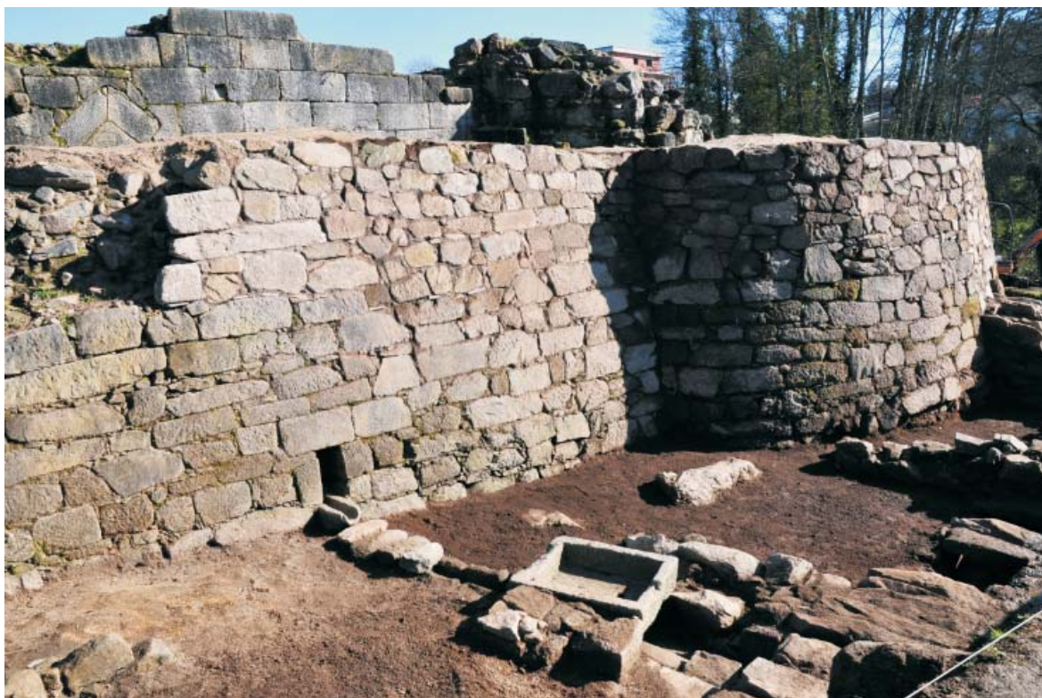
Detalle do interior e do exterior das estruturas do Sur do castelo. A drenaxe e limpeza exterior permiten a conservación dos muros, mentras que a restauración dos lienzos evita os derrubes cara ao exterior.
