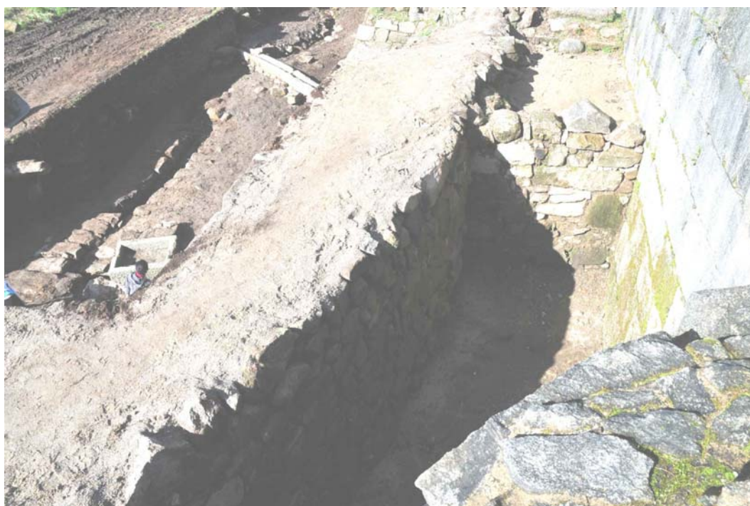
Estado do muro denantes e depois da intervención de restauración.
