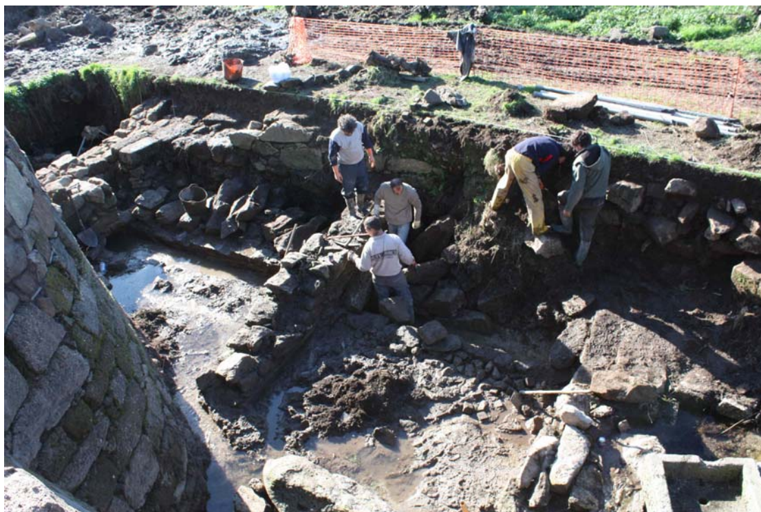
Traballos de reperfilado da sondaxe antiga, e limpeza e restitución do canle de saneamento na zona Sur.
