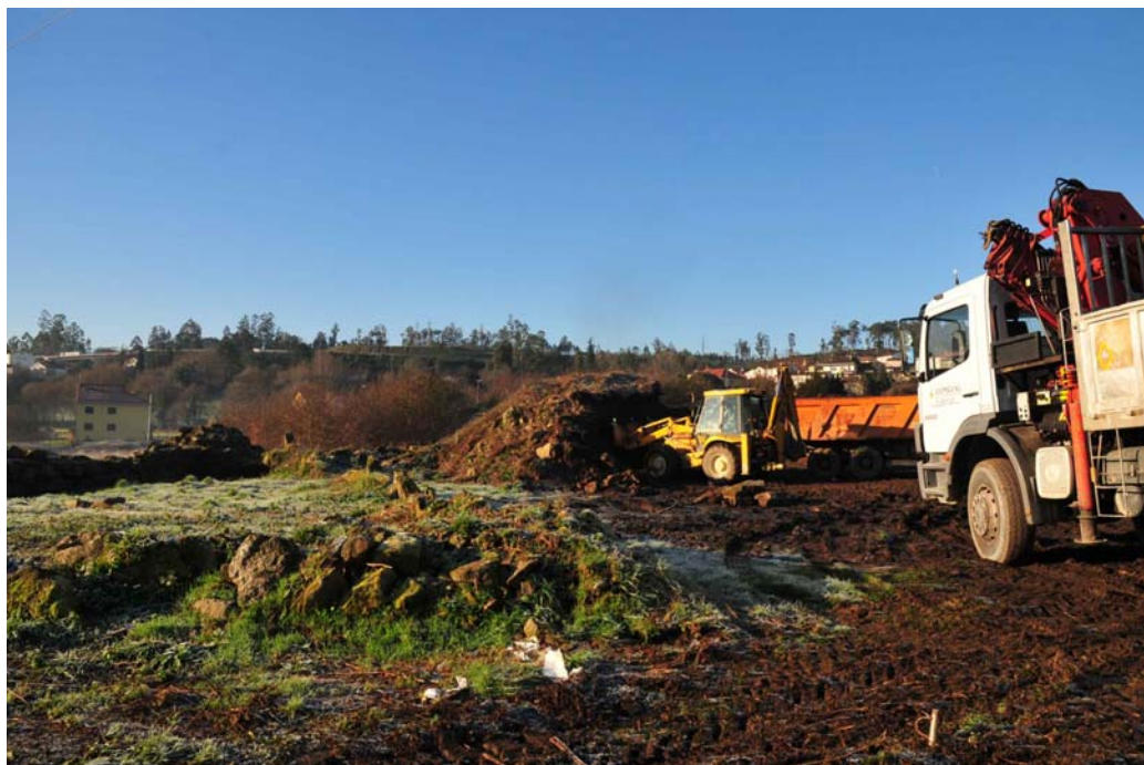
A retirada de escombreciras permitiu acopiar e recuperar elementos do mamposto.
