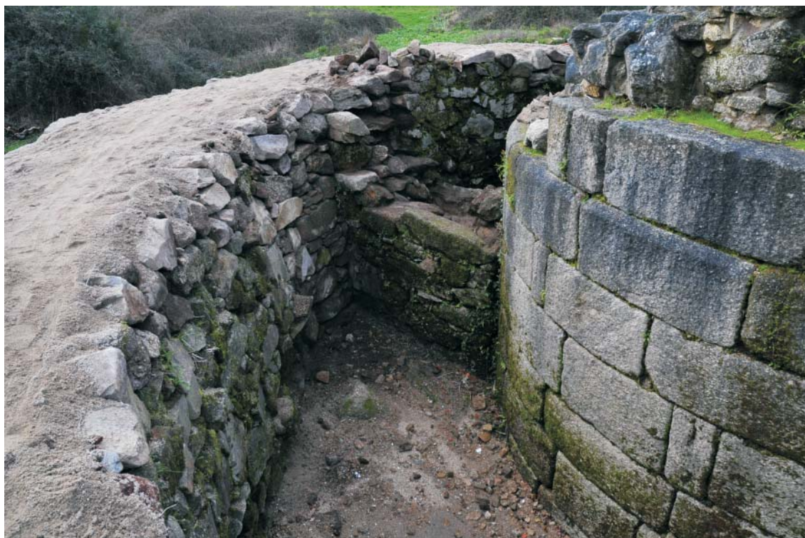
Vista do mesmo muro, no interior da liza, unha vez definida a estrutura e consolidada.
