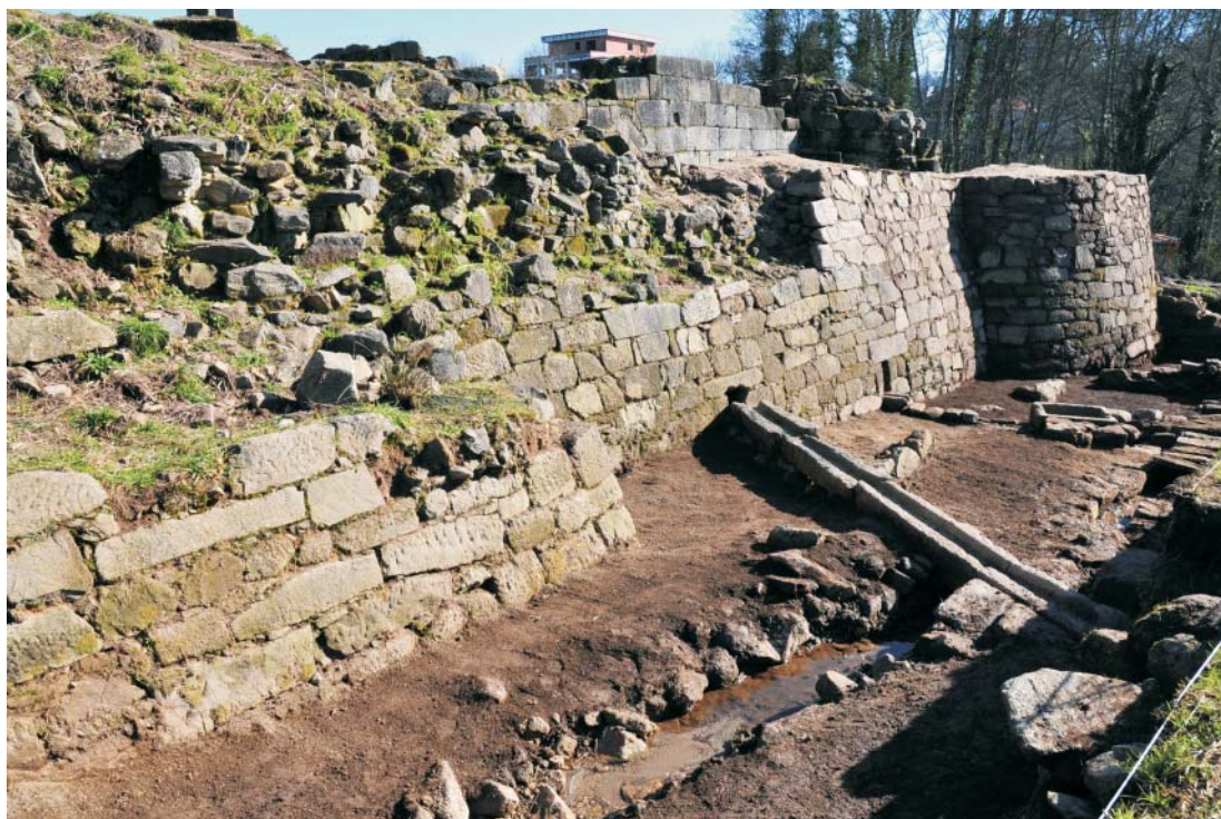
Vista xeral do sector Oeste e Sur. Estado final do sector sur unha vez rematados os traballos nas murallas e no exterior:
