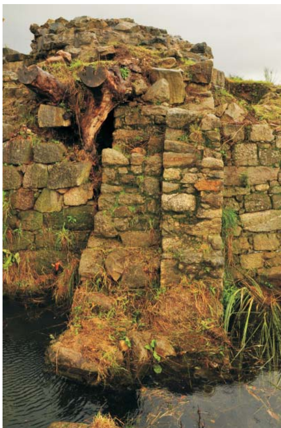
Vista xeral do estado do muro perpendicular amortizado durante a construción da antemuralla que foi recrecido en altura durante a súa restauración . Na derradeira foto vese o estado final do torreón Sur da antemuralla e do muro, na actualidade sen recrecer .
