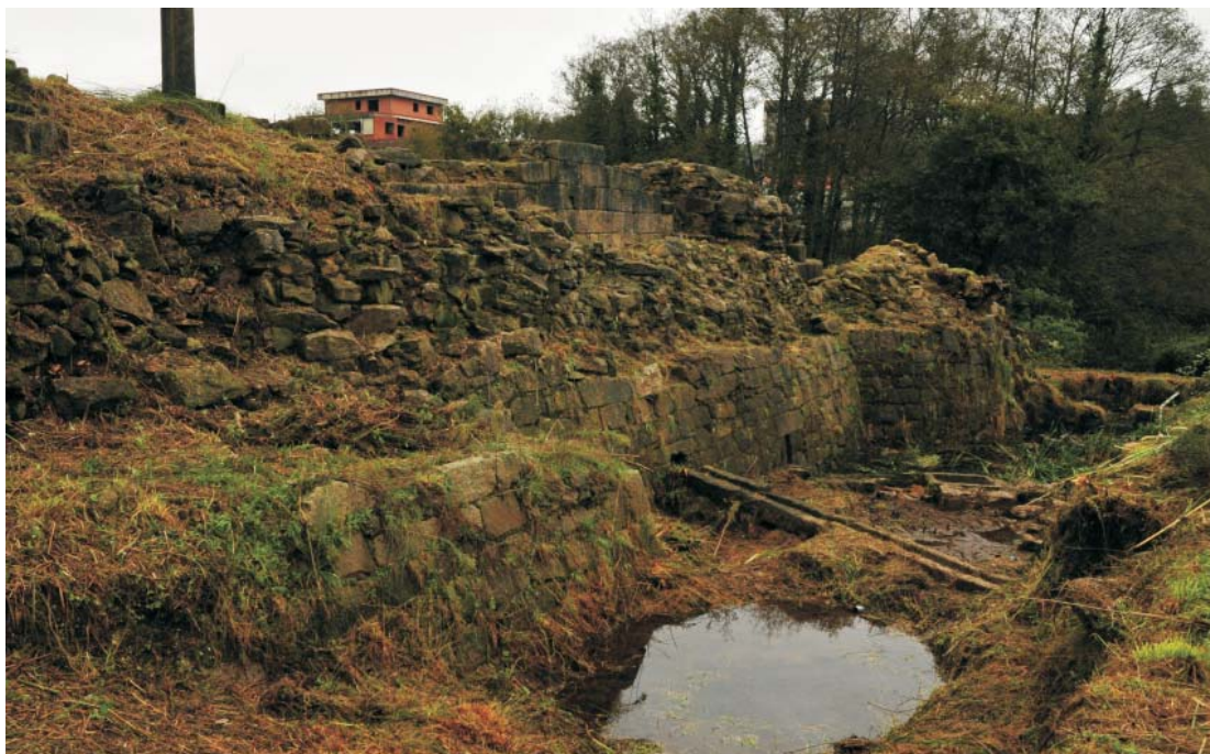
Estado no que se atopaban os restos ó escomenzo dos traballos de restauración, unha vez realizada a limpeza. Pódese apreciar como quedou ó aire o recheo da antemuralla
