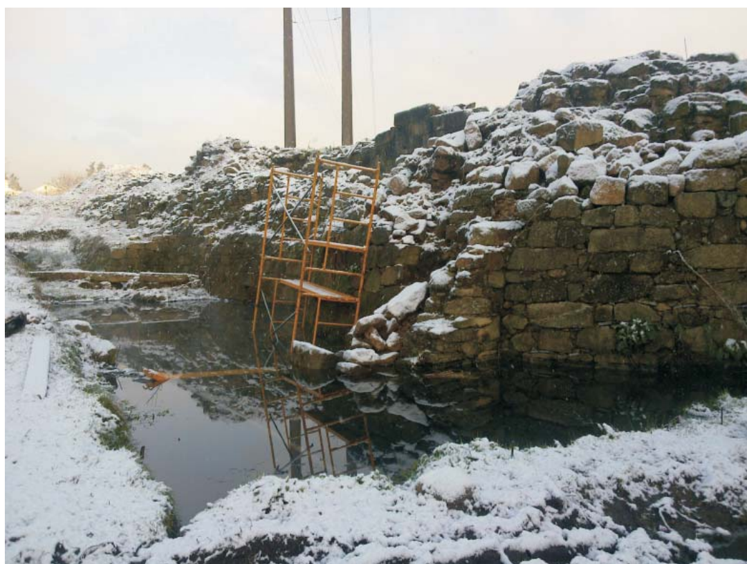
Dous aspectos do Castelo que reflicten as condicións nas que se executaron os traballos.
