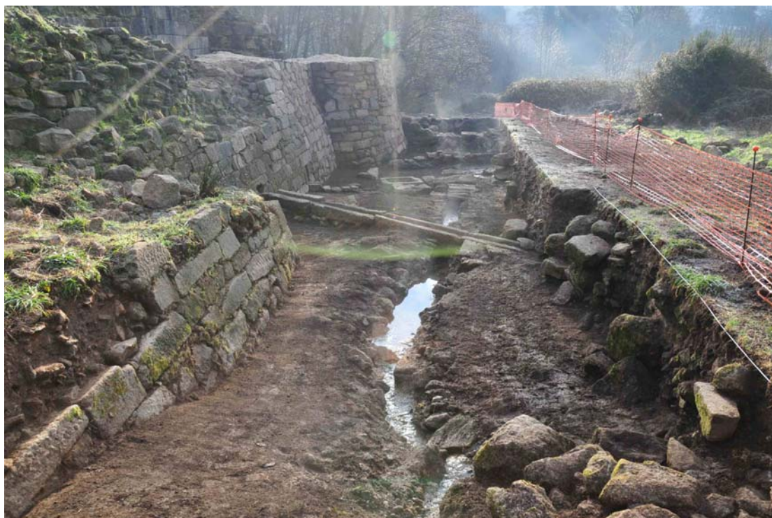
Vista xeral dende Oeste da recuperación dos drenaxes orixinais no exterior da muralla.
