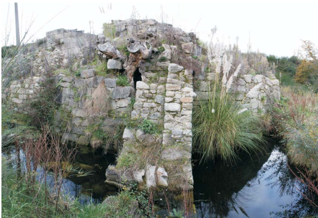
Vista xeral do torreón Sur dende o exterior. Aspecto inicial antes de escomenzar a limpeza.
