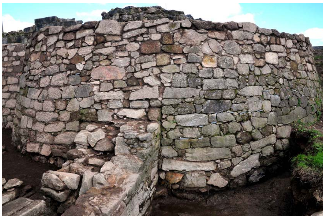
Vista dende o exterior do torreón sur da antemuralla, arriba denantes da intervención, unha vez desbrozado, abaixo, a recuperación do seu
