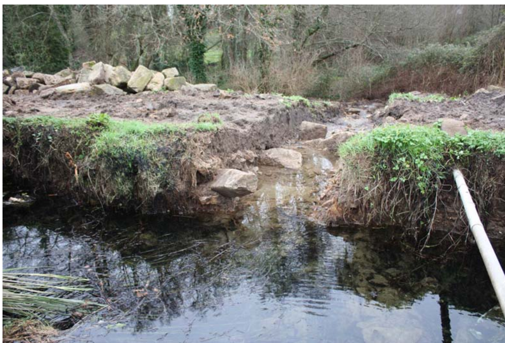
Vista xeral da escavación do sector 3 feito cara o saneamento.
