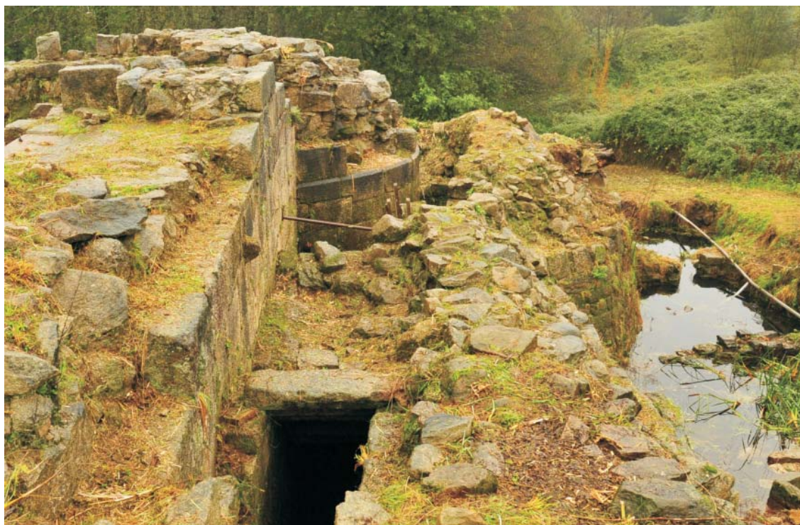
Vista xeral da liza no sector da poterna denantes de levar a cabo a restauración das estruturas..
