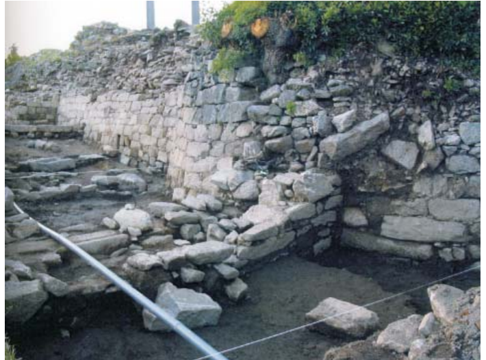
Detalle dos restos do muro orixinal amortizado na construción da antemuralla, denantes de ser restaurado.
