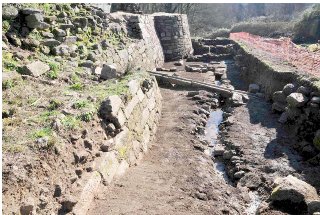
Vista xeral do sector exterior Oeste unha vez finalizada a intervención.
