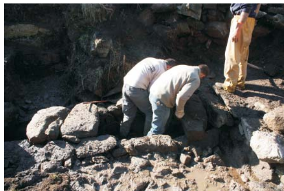
Traballos de limpeza e recuperación dos propios sistemas de drenaxe do castelo para evitar o alagamento.
