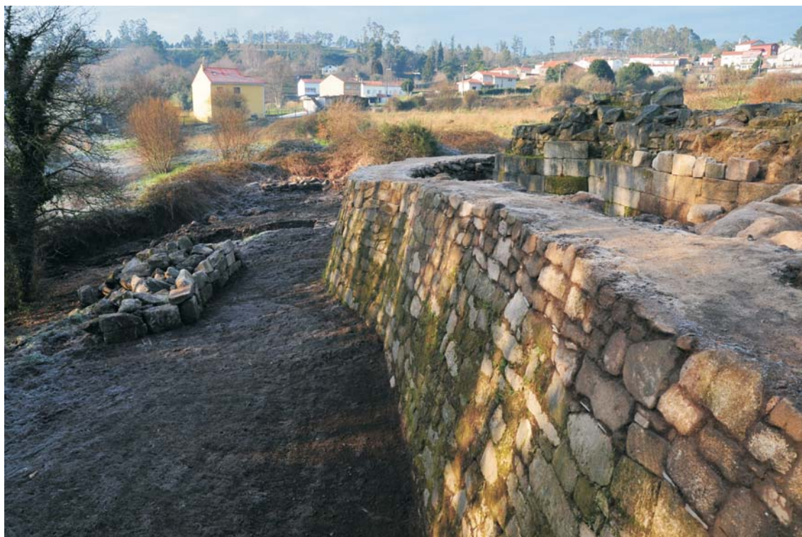
Aspecto final do lienzo da antemuralla e a zona exterior da mesma unha vez finalizada a intervención.
