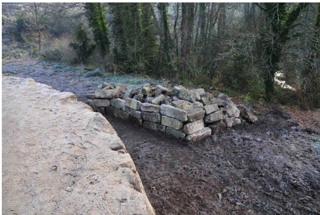
Limpeza e acondicionamento do espazos exterior ao Leste da muralla.
