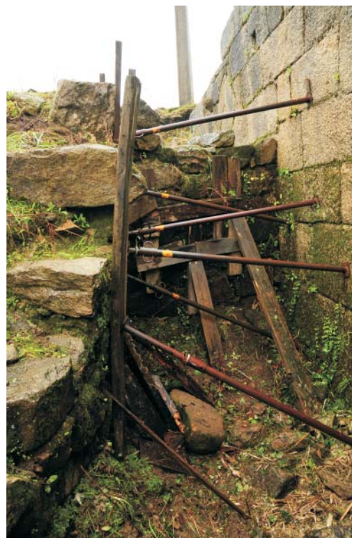
Detalles do estado previo do muro interior da liza, no sector Oeste, asociado a poterna de entrada, totalmente apuntalado .
