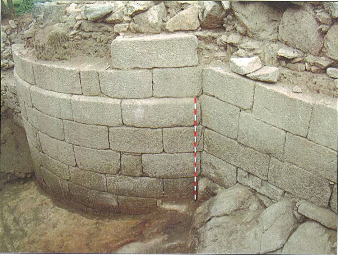
Sector 27/37. final de la Excavación.
