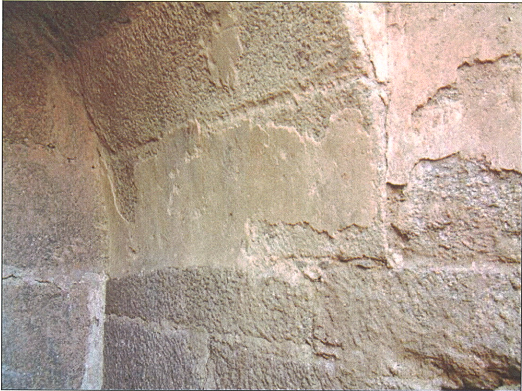
Detalle de restos de enlucidos
