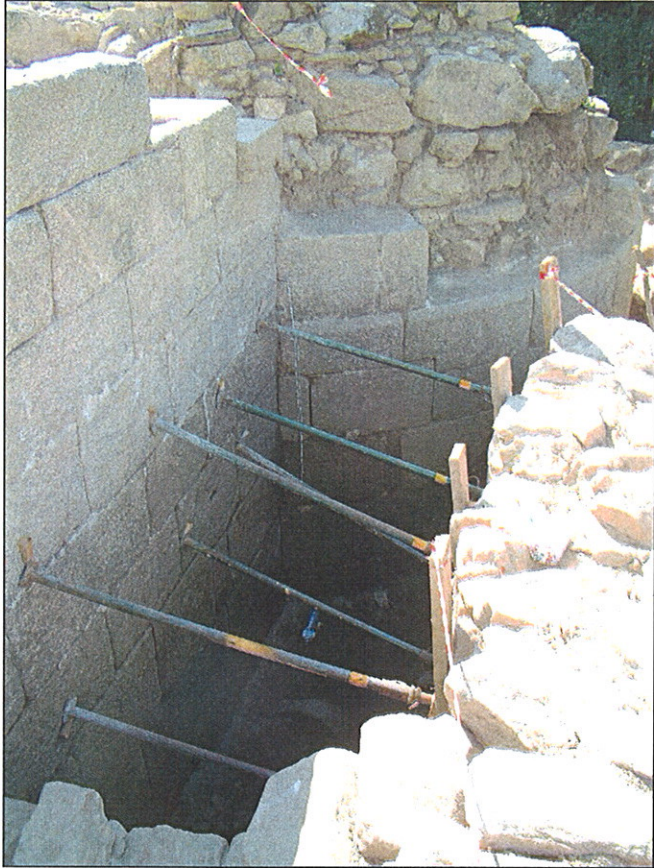
Sector 36 Vista de la zona entibada.
