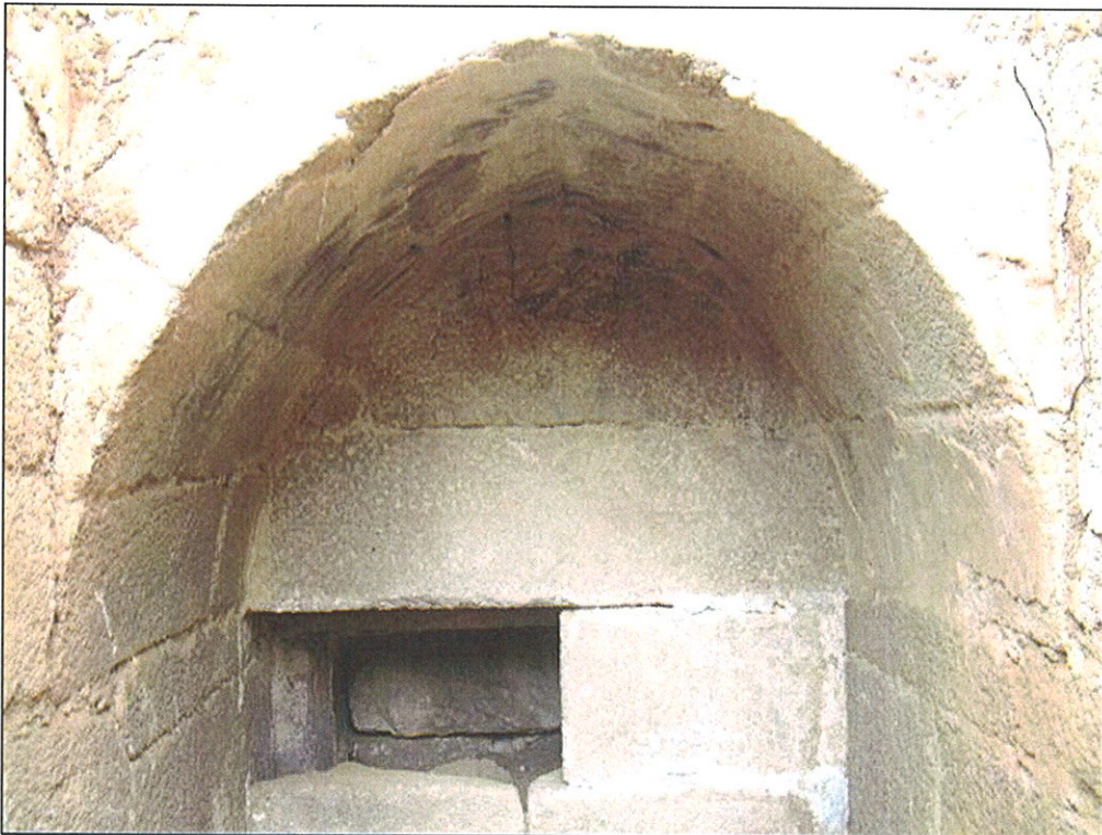
Detalle de la bóveda superior
