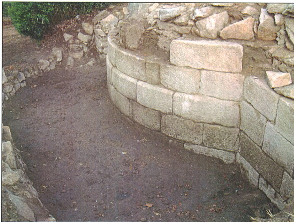
Sector 27/37 Liza y torreón en el transcurso de la excavación.
