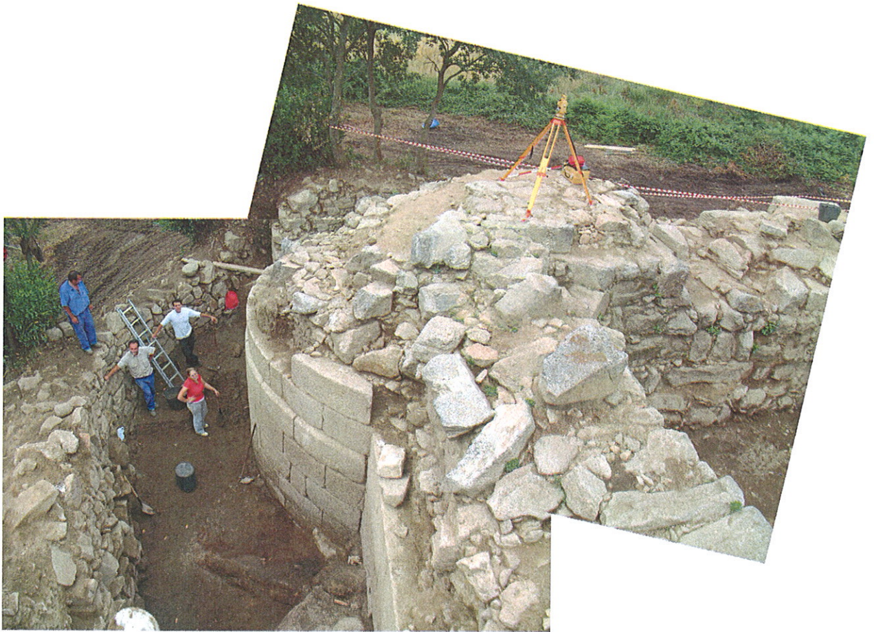
Vista de la estructura interior del torreón y la muralla.
