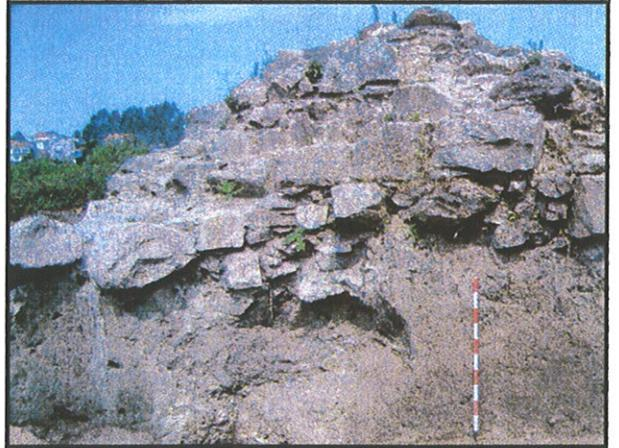
Fotos 224 y 225: Mampuesto de cimentación y relleno de torreón con alto riesgo de derrumbe.
