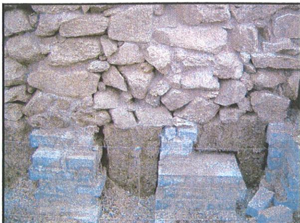
Foto 59: Bataches en ejecución por paramento Norte.
