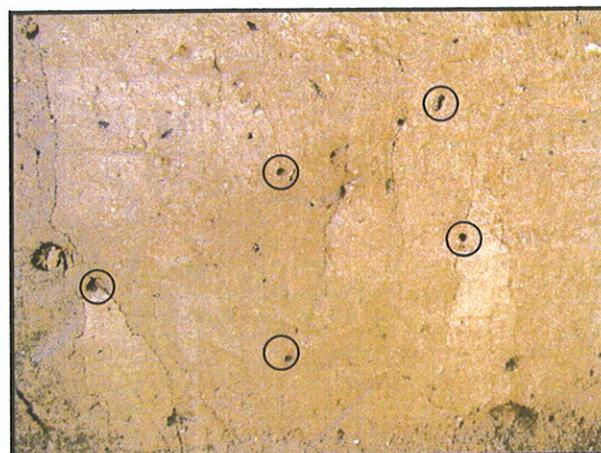
Foto 66: Perforaciones para inyección.
