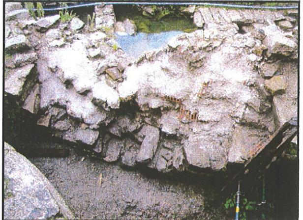
Foto 139 y 140: Vista de la malla sintética y mortero de cal para tomado de mampuestos.
