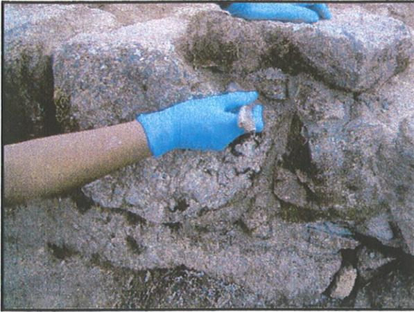
Foto 113: Consolidación e argamasa original con silicato.
