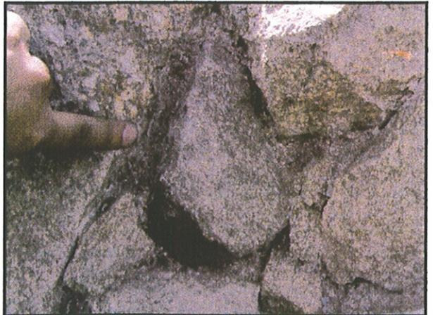
Foto 112: Detalle de aspecto de argamasa tras consolidación.
