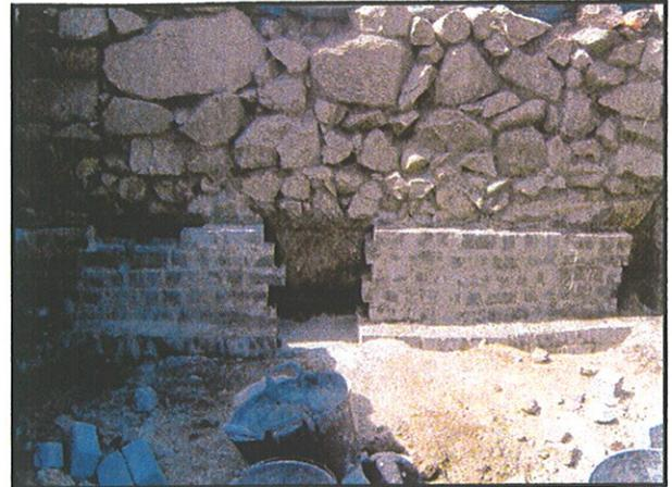
Foto 54: Vista de cómo se va conformando poco a poco la nueva cimentación de la estructura.
