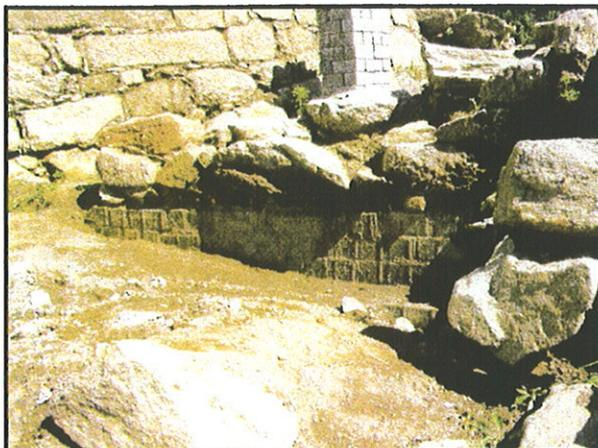
Foto 47: M19 extremo Este durante recalce con adoquín.
