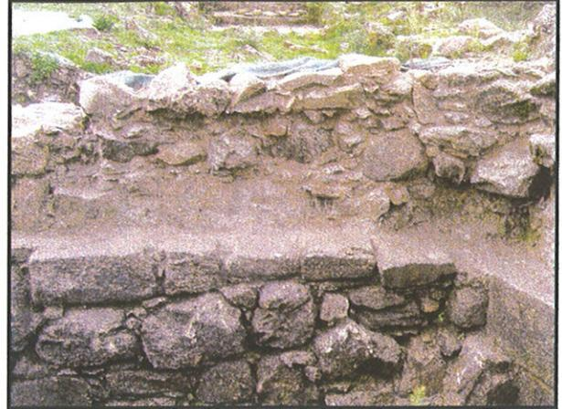
Foto 108: Detalle de consolidación de relleno de M1. Salida.
