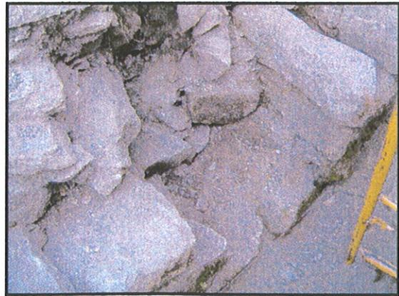
Foto 131 y 132: Aspecto que presenta el paramento interior tras desmontaje y nivel al que se llegó.
