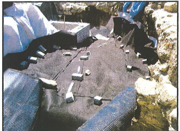
Fotos 230 y 231: Colocación de lámina drenante.
