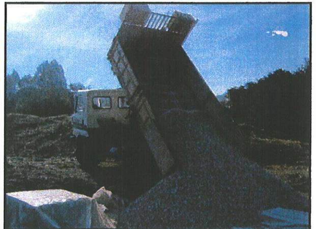
Fotos 226 y 227: Colocación de geotextil y llegada de grava.
