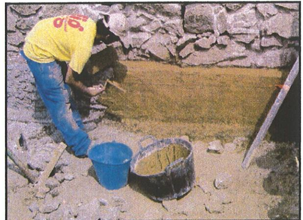
Foto 56: Aplicación de revoco con color con llana y paleta.
