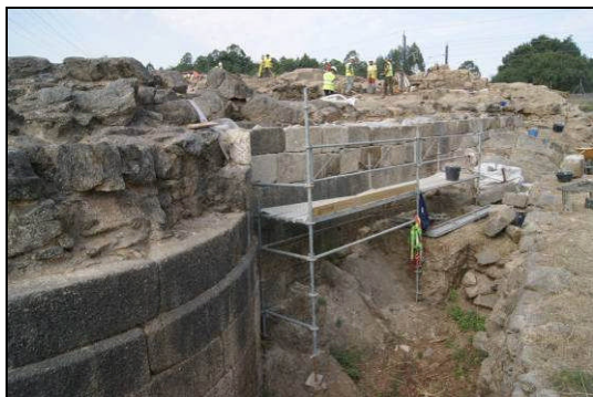
Traballos de restauración no lenzo suroeste da muralla. Dende o noroeste.
