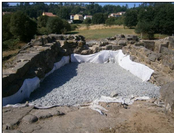
Recheo con grava na sala 1
