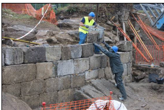
Traballos de restauración no lenzo surleste da muralla, preto do torreón oriental. Dende o sur.
