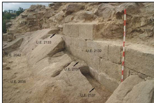
Estruturas murarias: Relación da muralla (UE2132) na zona surlleste con outras UES. Dende o leste.
