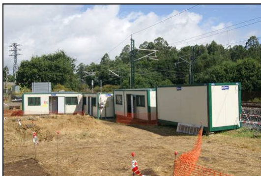
Zona acondicionada para casetas de obra. Dende o sur.
