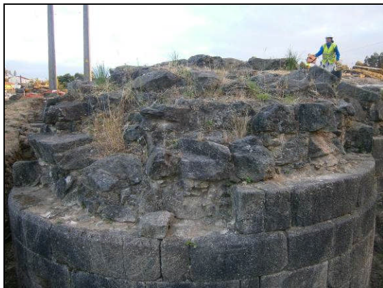
Aspecto inicial do torreón sur antes da limpeza.
