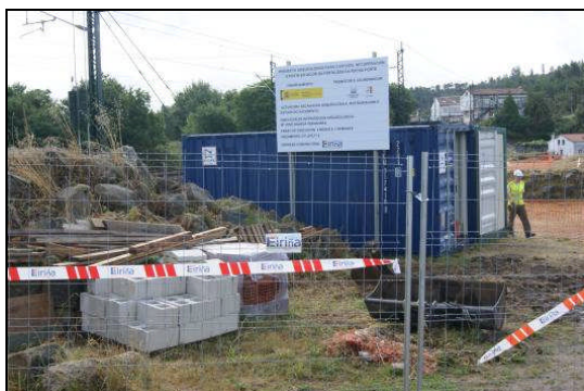
Zona de acopio de materiais, xunto ao cartel de obra. Dende o norte.
