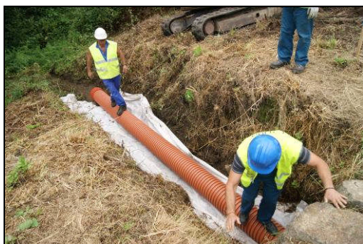
Zona exterior do castelo: colocación de tubo para drenaxe. Dende o norte.
