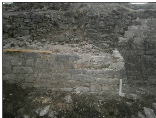
Traballos de restauración no baluarte suroeste. Dende o suroeste.
