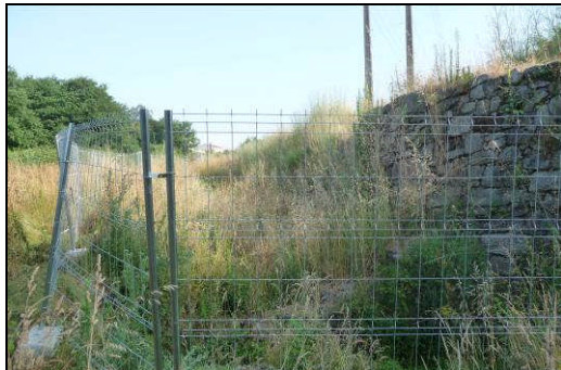
Vista no sector oeste exterior do castelo antes dos traballos de desbroce. Dende o sur.
