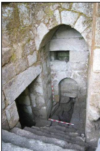
Sala Alxibe 1, con dúas fases construtivas.
