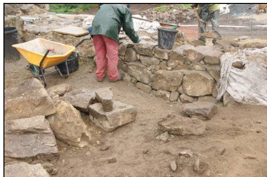
Parcheado de muros interiores do castelo. Muralla interior suroeste. Dende o norte.
