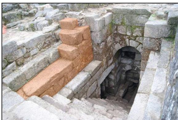
Vista do reforzo estrutural UE3021.
