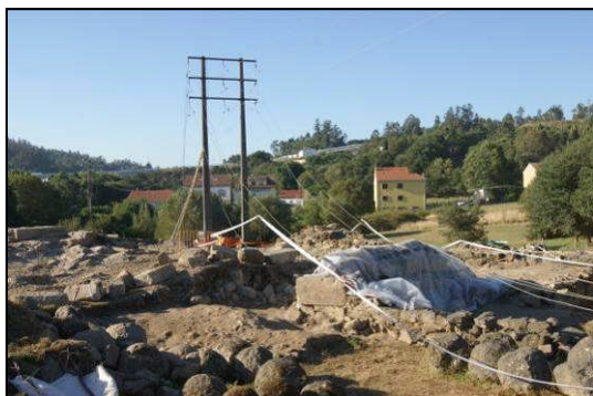
Eliminación do tendido eléctrico no lado oeste do castelo: Retirada dos cables. Dende o norte.
