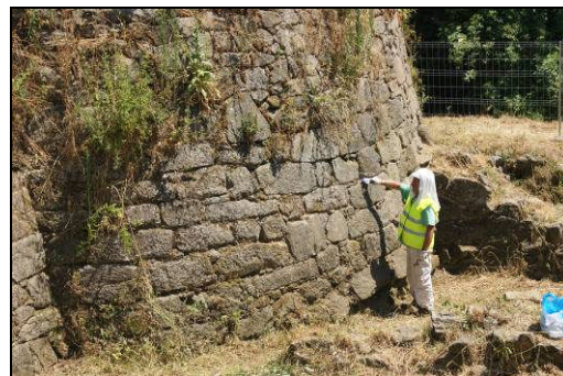
Detalle do traballo de limpeza de paramentos exteriores, zona oeste. Dende o norte.
