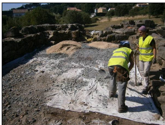
Novo recheo con grava na sala 1
