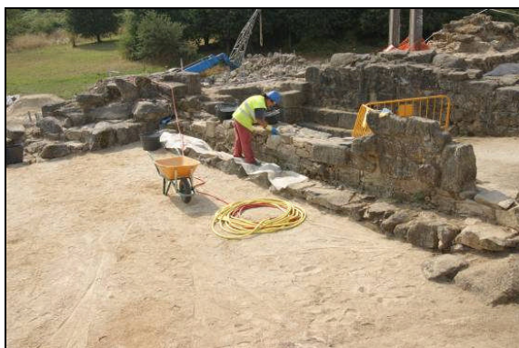
Parcheado de muros interiores do castelo. Muro noroeste da Sala 1. Dende o leste.
