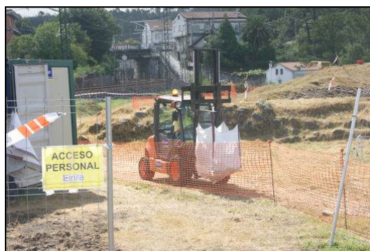
Evacuación das terras escavadas con axuda mecánica. Dende o norte.
