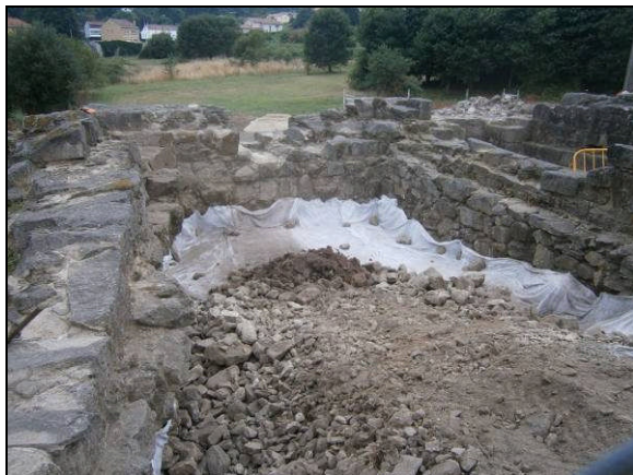
Recheo con pedra na sala 1
