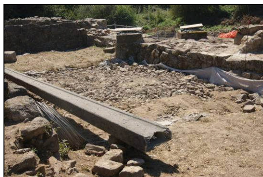
Eliminación do tendido eléctrico no lado oeste do castelo: Zapatas sobre a muralla. Dende o norte.
