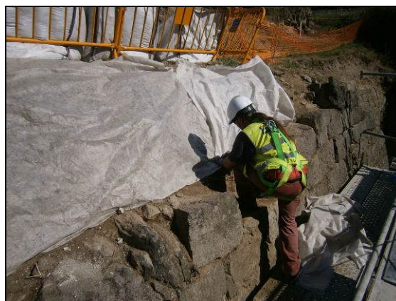
Protección de perfís con xeotextil.
