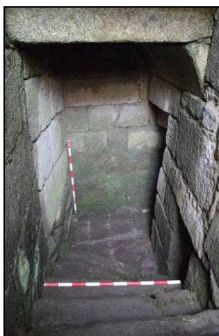
Zona canalizacións, con parede selada.
