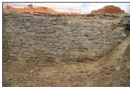
Lenzo exterior na zona surlleste, unha vez limpo. Dende o sur.
