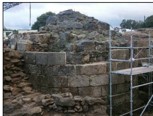
Proba de patinado sobre a pedra do aserradeiro no torreón oeste. Dende o noroeste
