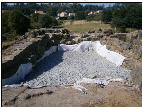
Estado final do botado de area
