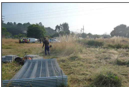
Traballos de roza no interior do castelo, zona oeste. Dende o oeste.
