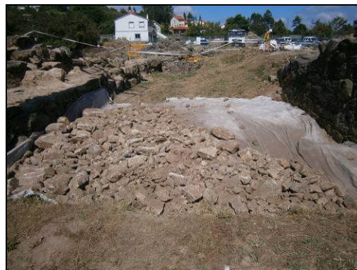
Traballos de recheo na Sala 2. Dende o surleste.
