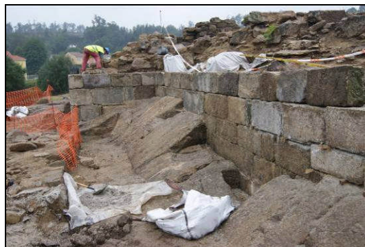
Traballos de restauración no tramo surleste da muralla e no torreón surleste. Dende o noreste.
