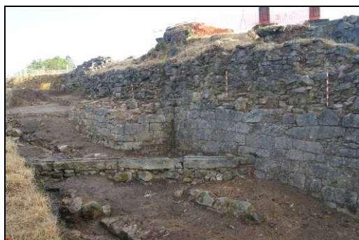
Paramentos exteriores da zona oeste, unha vez limpos. Dende o sur.
