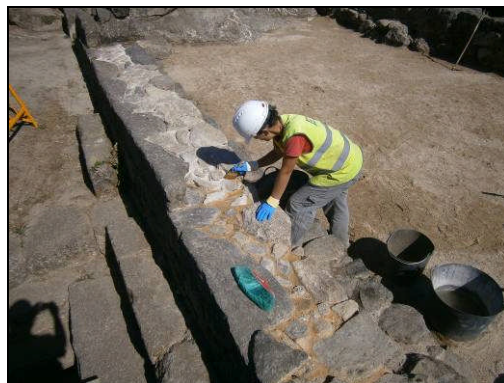
Protección de cabeceiras de muros restituídos. Tinguído da cabeceira do muro noroeste da Sala 1. Dende o oeste.
