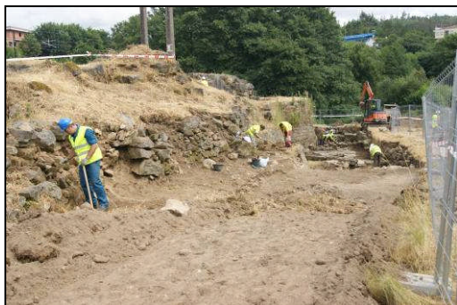
Traballos de limpeza dos paramentos exteriores da zona oeste. Dende o noroeste.
