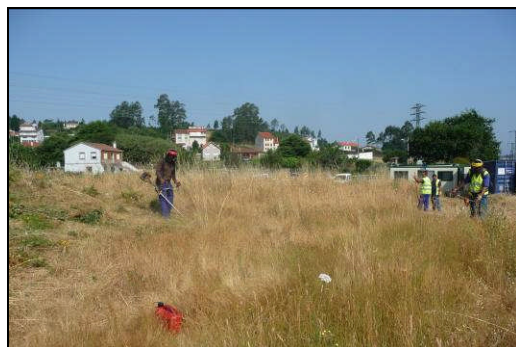
Traballos de roza no interior do castelo, zona central. Dende o sur.
