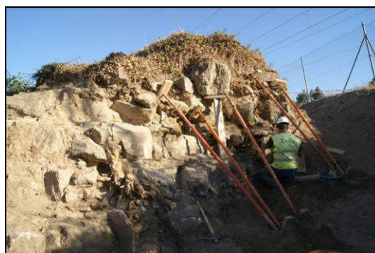
Apuntalamiento da torre leste do castelo. Dende o suroeste.
