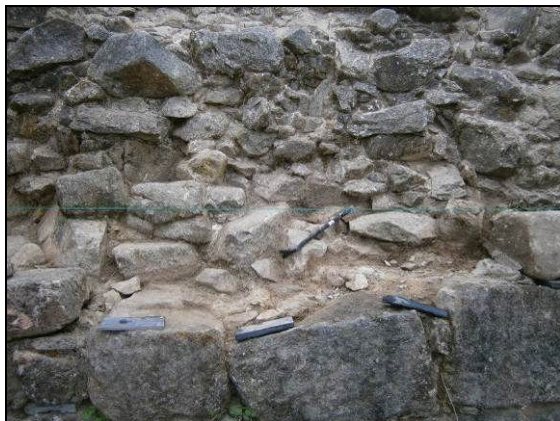
Colocación dos elementos diferenciadores.
