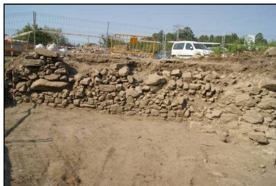
Sector 5: Estrutura documentada ao norte do sector, a xeito de muro de contención. Dende o sur.
