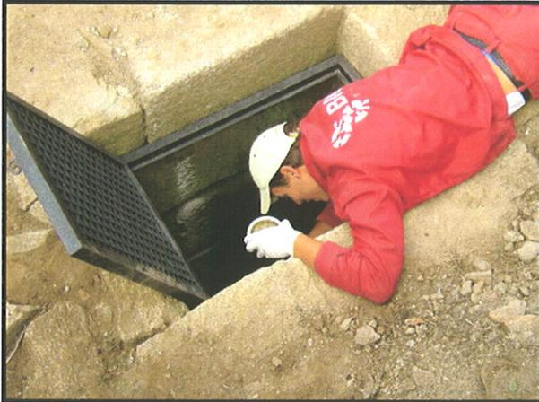
Foto 131: Aplicación de resina epoxi en hueco taladro.
