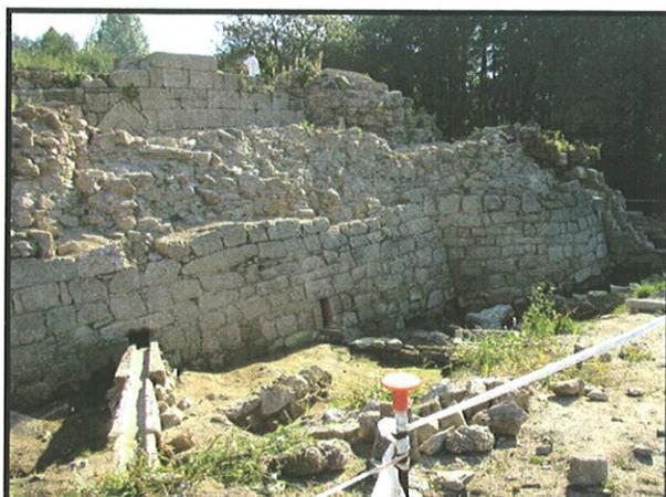
Foto 48: Estado final del relleno de M2 tras consolidación del mismo.
