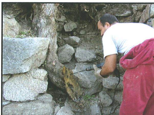
Foto 142: Ejecución de taladros para inyección de tordón.
