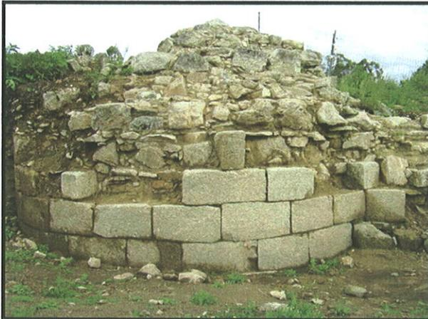
Foto 40: Vista general de torreón Oeste tras consolidación y aterrazamiento.
