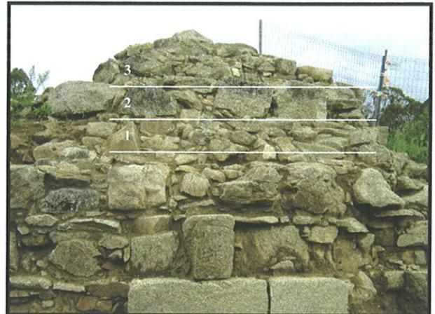
Foto 41: Vista parcial de torreón Oeste tras consolidación y líneas de aterrazamiento.
