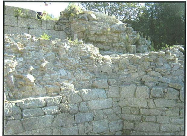
Foto 53: Vista del relleno en unión paramento y torreón Sur. Final.
