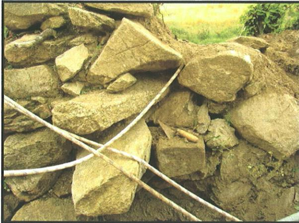
Foto 60: Estado de hiladas superiores de paramento interior de M2. Riesgo de desplome total.
