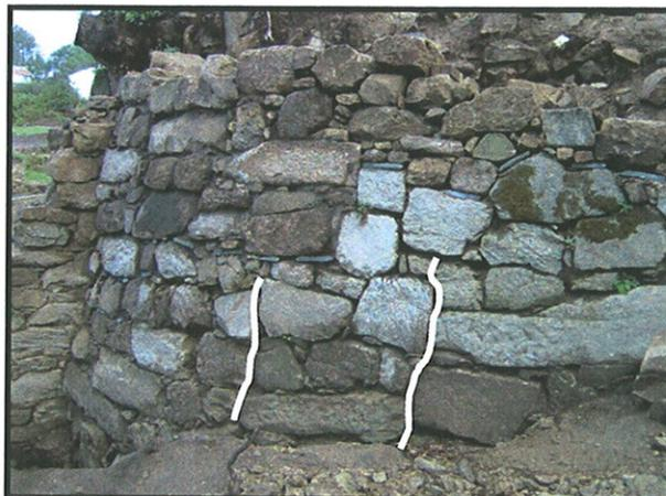
Foto 11: Ejemplos de llagas (junta vertical) “no matadas”.
