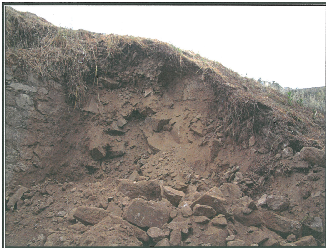
Vista do derrube que cubría á barbacá e ao bastión.
