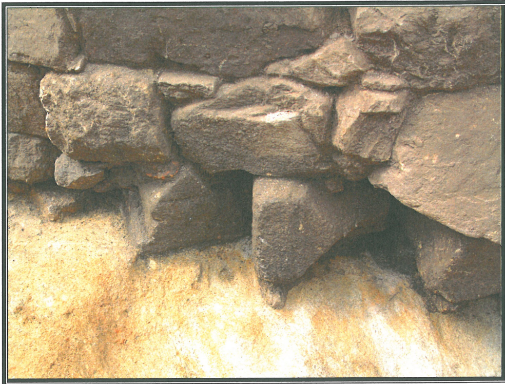
Vista dos elementos reutilizados na construción da barbacá UEM 228.
