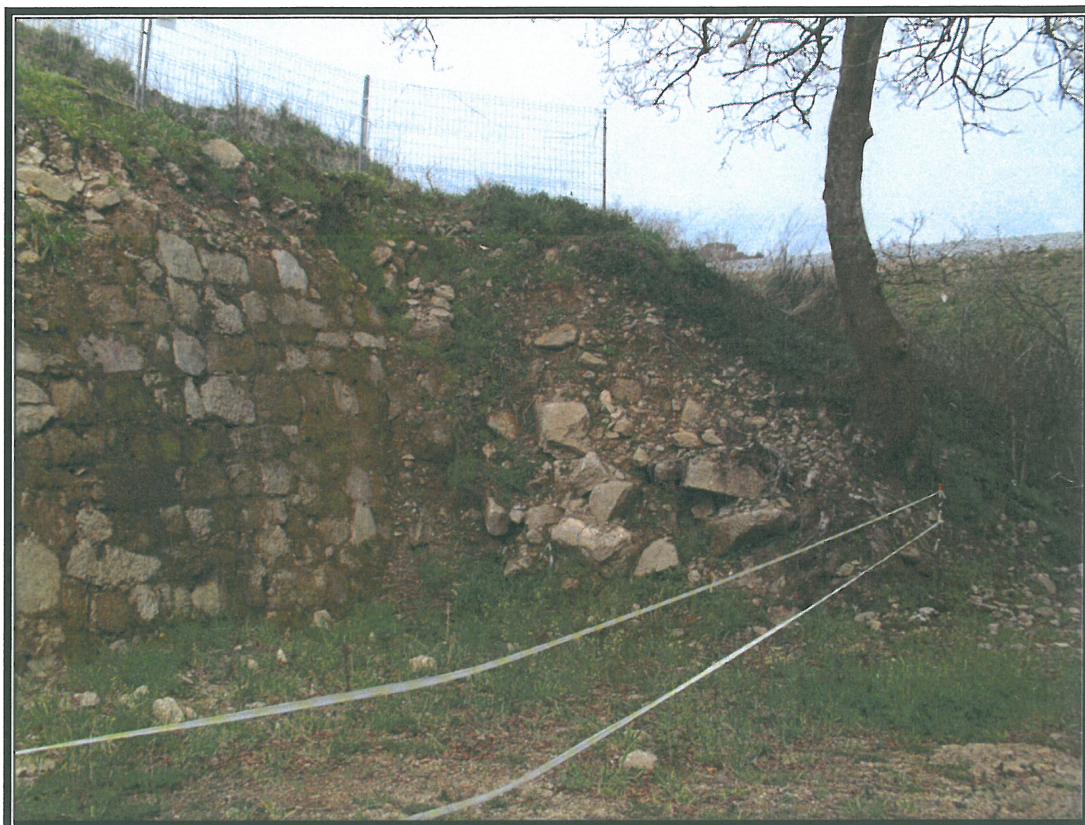
Vista da zona de actuación antes de comezalos traballos.
