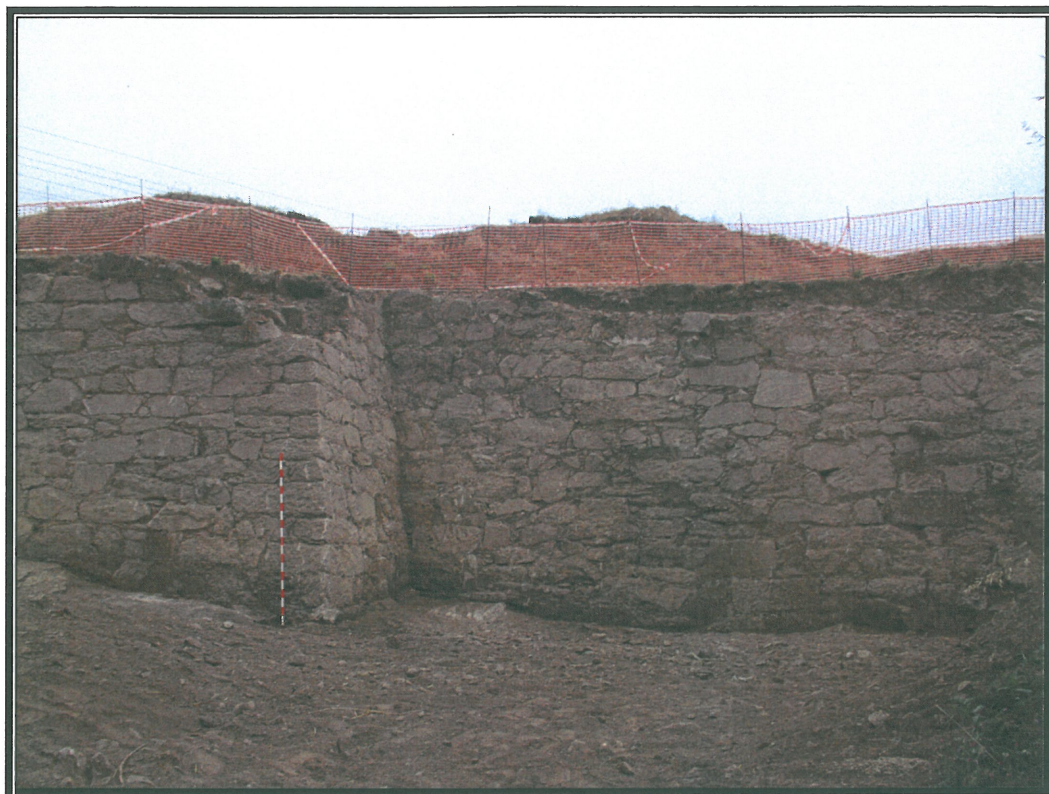
Vista do bastión e da barbacá no seu tramo sureste.
