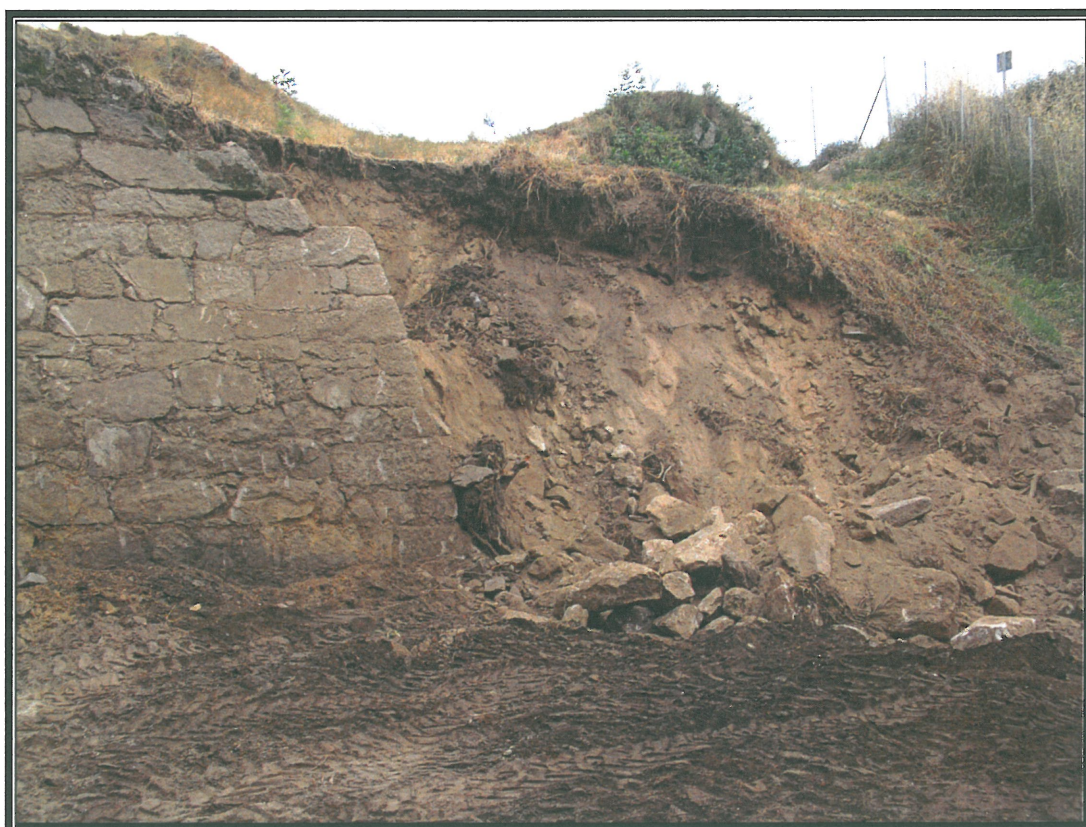
Vista do proceso de limpeza e retirada de escombros no tramo máis oriental.
