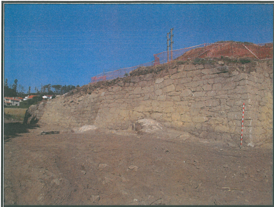
Vista do Bastión e da barbacá no seu tramo suroeste, en segundo plano.
